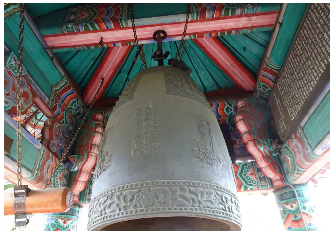
千葉県八千代市観音寺の鐘楼
